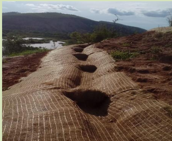
Execução de canaleta verde com dissipadores de energia de água pluvial
