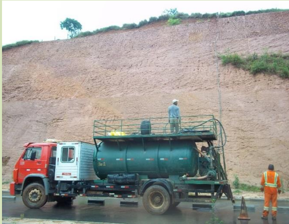
Execução de hidrossemeaduras em taludes
