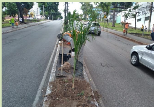
Execução de plantio
