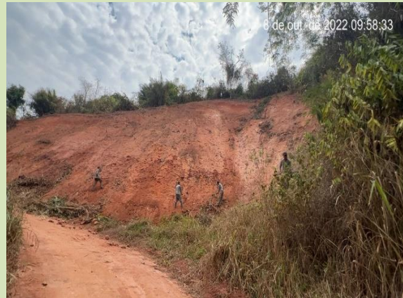
Preparação inicial para revegetação do talude
