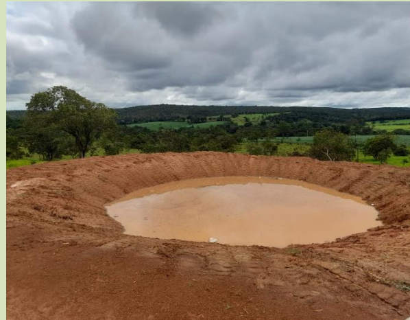
Execução de bacias de contenção (barraginhas)
