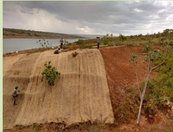
Revegetação de taludes e aplicação de biomantas
