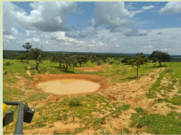
Execução de bacias de contenção (barraginhas)
