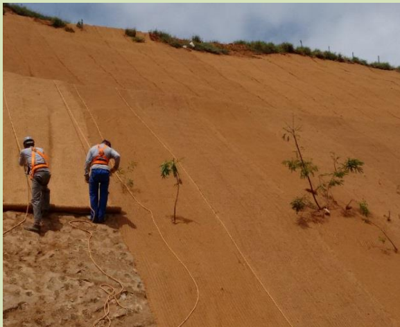
Aplicação de biomantas de fibra de côco em taludes
