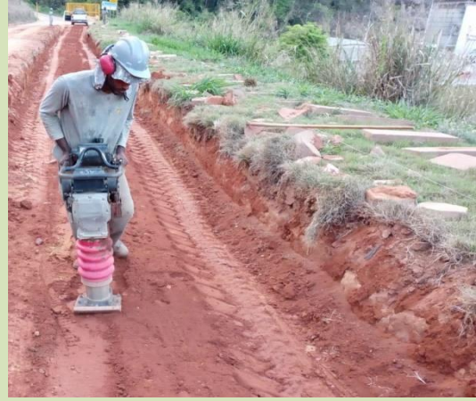
Compactação manual de aterros
