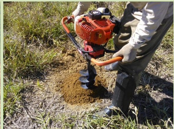
Operações de coveamento
