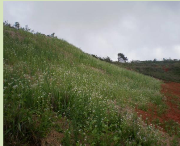
Revegetação de taludes com aplicação de biomanta
