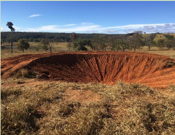
Execução de bacias de contenção (barraginhas)
