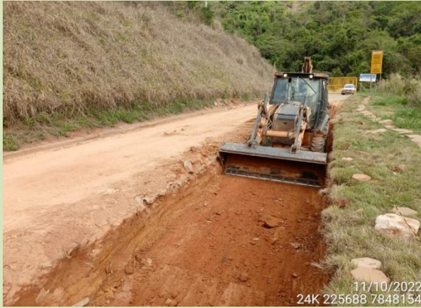
Readequação de vias
